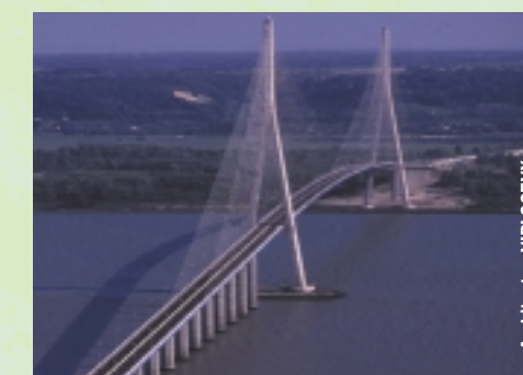
Pont de Normandie
